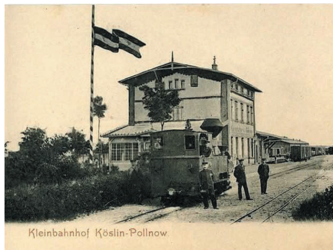
1904 r. – stacja kolejki wąskotorowej w Koszalinie, źródło: Deutsche Fotothek
